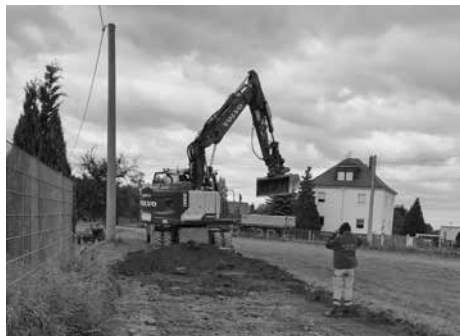
Bauarbeiten am Kirchweg Reichenberg
