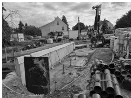
Baustelle Brücke über den Bindebach OT Steinbach
