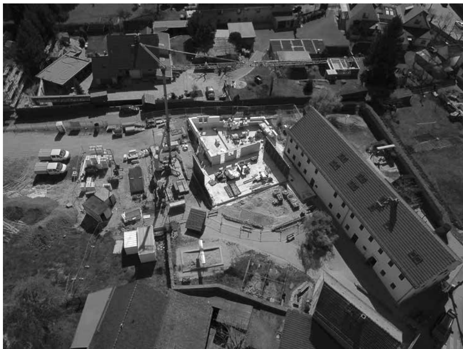
Baustelle Hort Reichenberg
