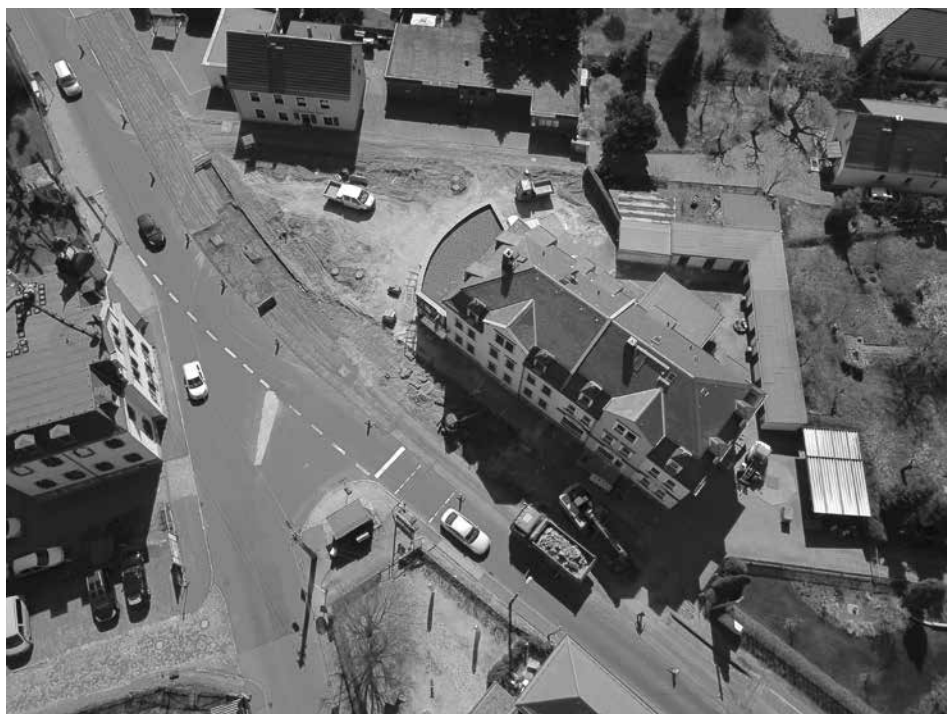
Baustelle Haltestelle Boxdorf
