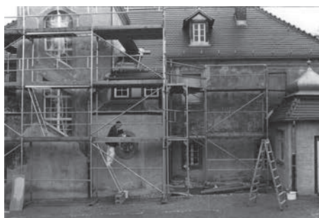
Das Käthe Kollwitz Haus zur Zeit der Sanierung 1994
