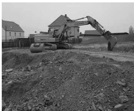
Bagger an der Kita Kleeblatt
