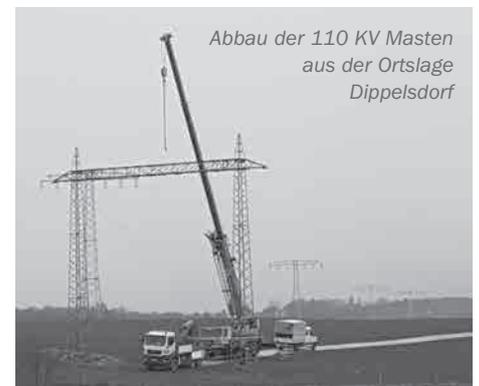
Abbau der 110 KV Masten aus der Ortslage Dippelsdorf
