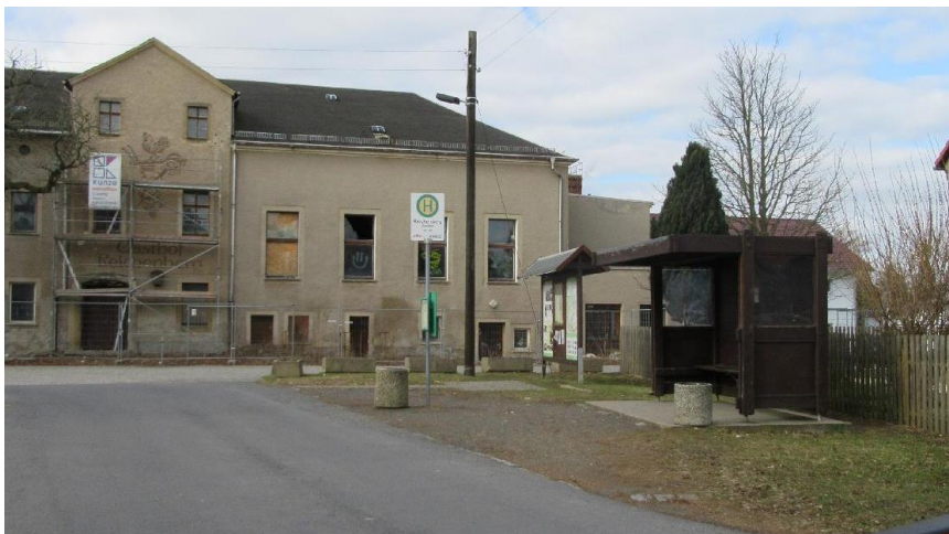
Foto: Unterstand des Haltesteiges 2 an der Haltestelle Reichenberg-Gasthof im Bestand
